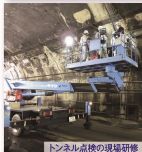
トンネル点検の現場研修
