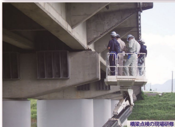
橋梁点検の現場研修
