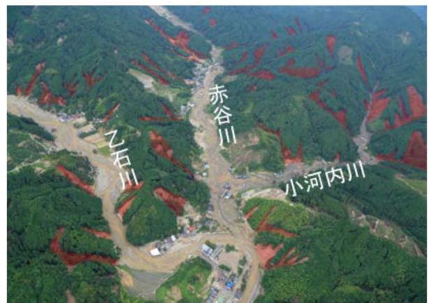
写真-1 赤谷川流域で発生した斜面崩壊
