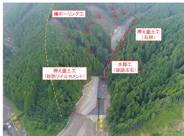
写真5 応急対策工の実施状況
