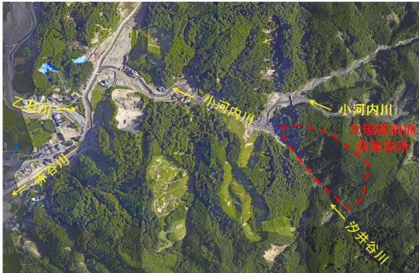
写真-2 大規模斜面崩壊地周辺の状況
