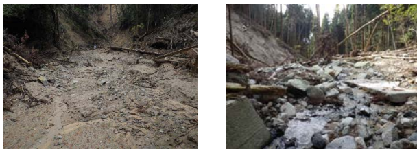
写真-2 谷出口の土砂堆積状況 (右：真砂土主体、左：変成岩主体)
