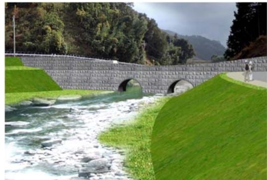
図-3 大暗渠砂防堰堤のイメージ
