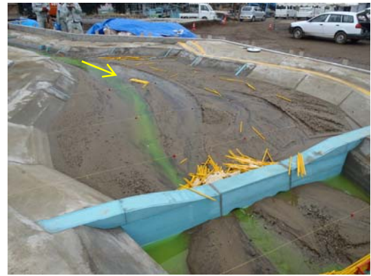
写真-10 洪水末期における土砂流木堆積状況
