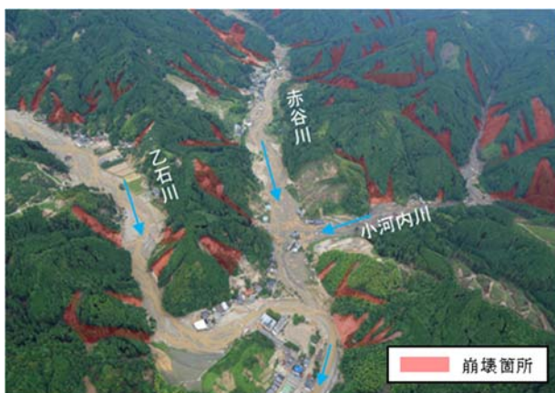
写真-1 赤谷川流域で発生した斜面崩壊 (H29.7)
