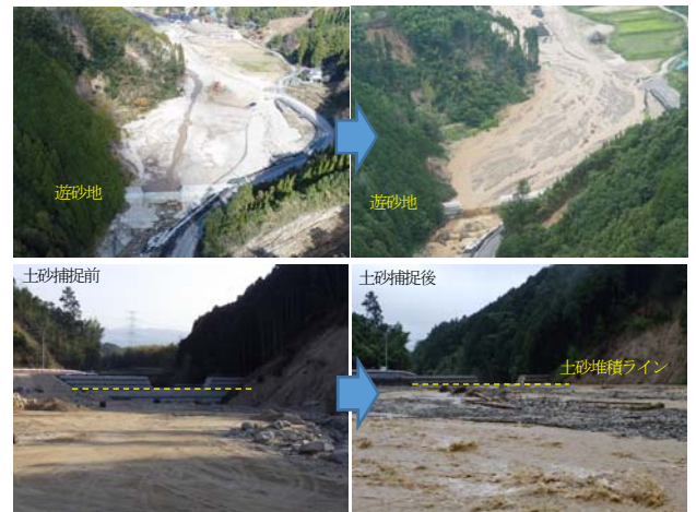
写真-4 乙石川遊砂地(応急対策施設)土砂捕捉状況 (平成30年:左上下, 令和元年:右上下)
