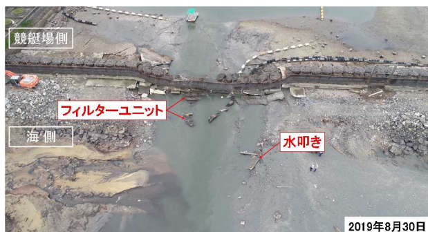
図-4 被災状況位置関係
