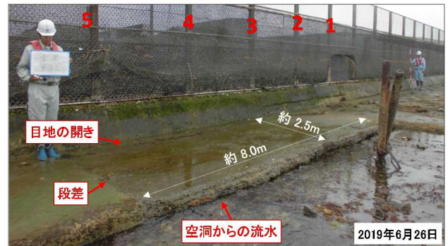
図-10 空洞化調査位置と空洞化状況
