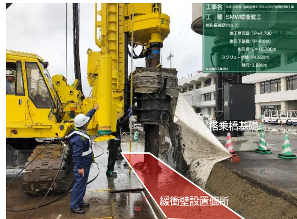
写真-1 SMW施工中写真
