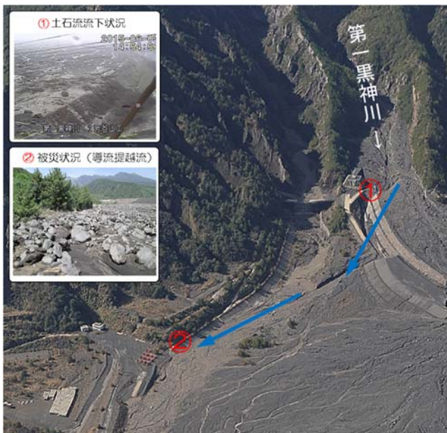
図-4. 平成27年6月の土石流流下状況
