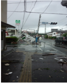
(写真-2) 看板被害
