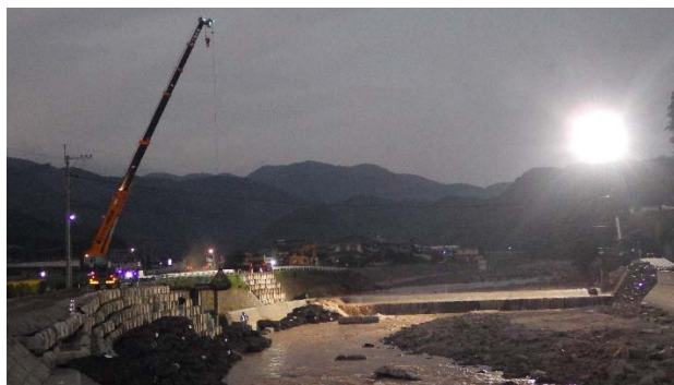
写真 4 夜間の応急復旧作業に伴い照明車を配備
