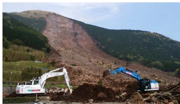
写真-3 無人化施工機械による土砂撤去作業（国道 57 号）
