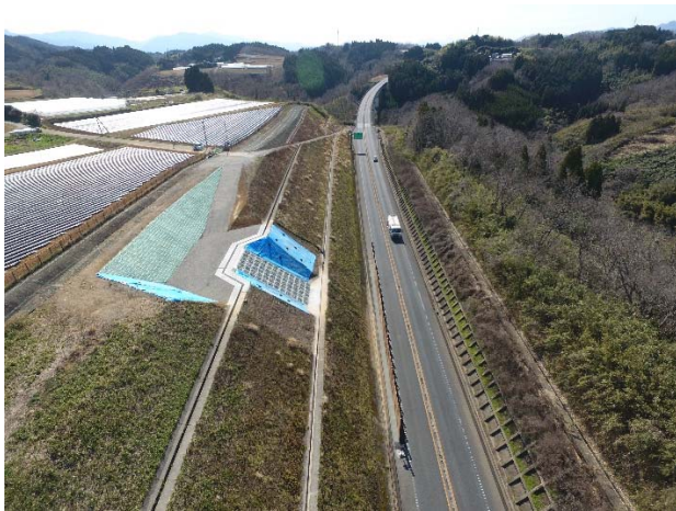
写真-6 被災法面の復旧状況と前後区間の法面状況 (左側)
