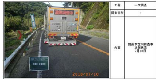
図-7 一次調査計測状況
