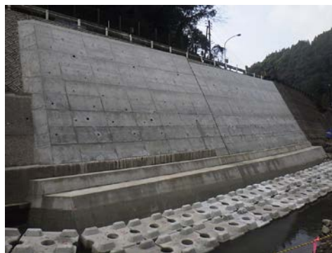
図-12 本復旧工事終了後の擁壁
