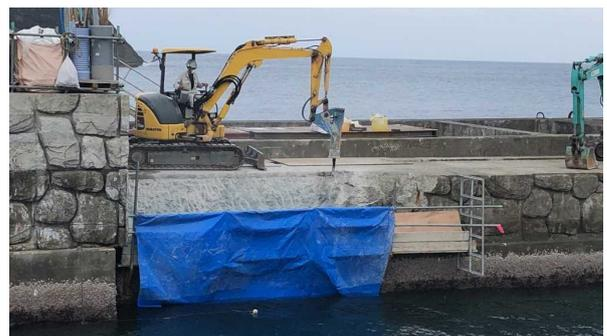
写真-2 上部工破損箇所 はつり状況
