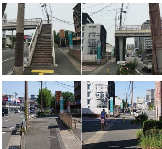
図-8 歩道橋撤去前後の比較(上:撤去前,下:撤去後)
