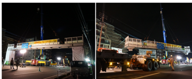
図-7 千早歩道橋撤去工事の様子
