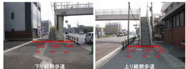
図-4 歩道橋階段部の様子(名島歩道橋)
