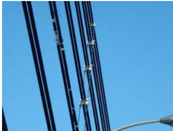
写真-4 平行連結方式の制振ワイヤ
