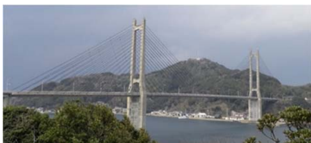
写真-1 呼子大橋
