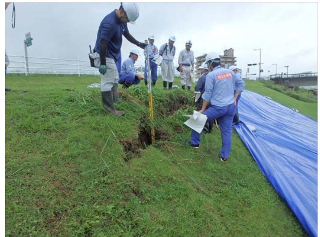
テックドクターによる現地調査
