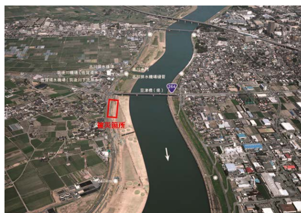
被災箇所の上空写真
