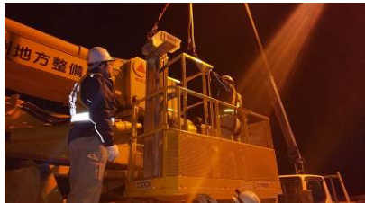
写真-5 昇降装置取付状況
