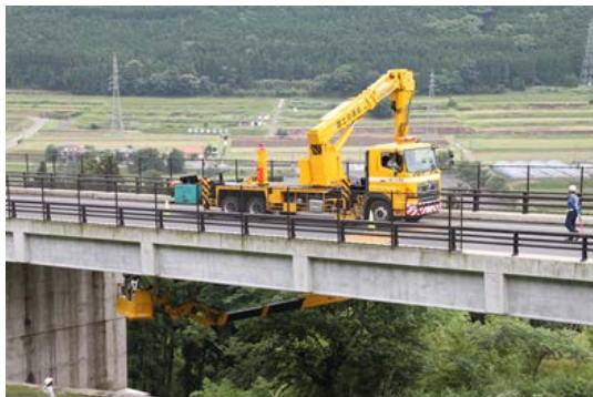
写真-1 橋梁点検車での点検状況
