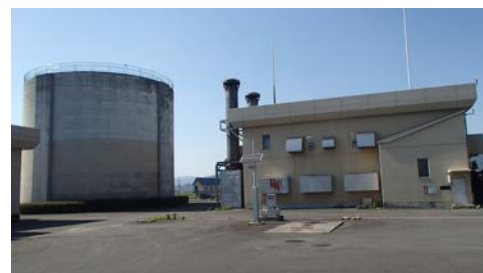
写真-1 巨勢川ポンプ場（東澁系）外観
