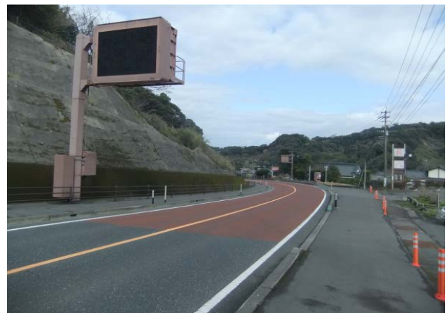
図-5 国道 220 号 143k 付近のカラー舗装（垂水市内から桜島方面を望む）
