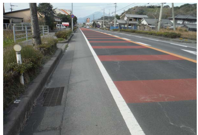
図-6 国道 220 号 151k 付近の平行ゼブラ舗装（垂水市内から桜島方面を望む）
