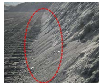
写真-4 掘削後の法尻への堆積
