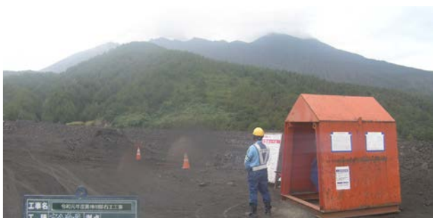
写真-5 噴石監視員による山体監視状況
