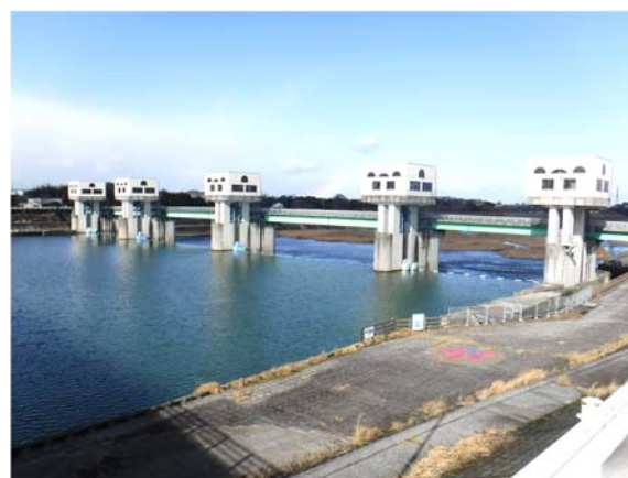
図2 平成大堰の全体写真
