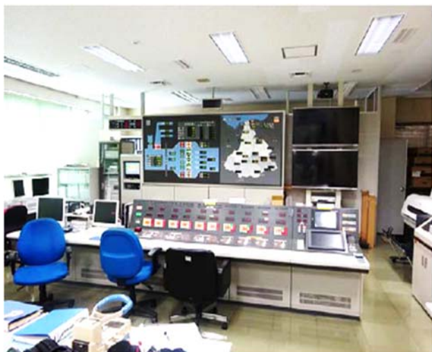
図3 旧堰コンの全体写真
