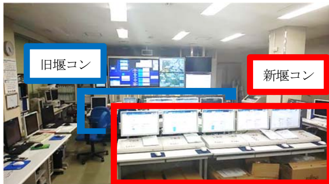
図7 旧堰コンと新堰コンの併設
