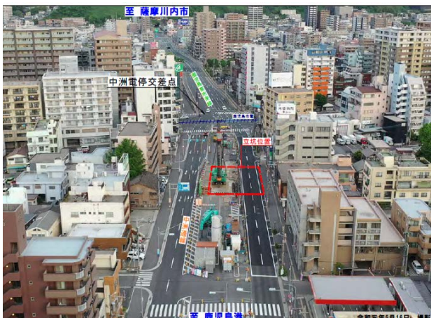
図-4 立坑周辺状況
