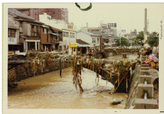
写真8 長崎大水害による被害状況（眼鏡橋付近）
