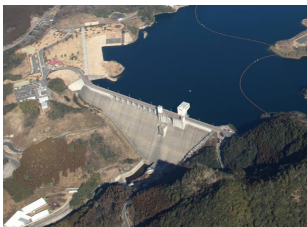
写真-1（竜門ダム堤体写真）
