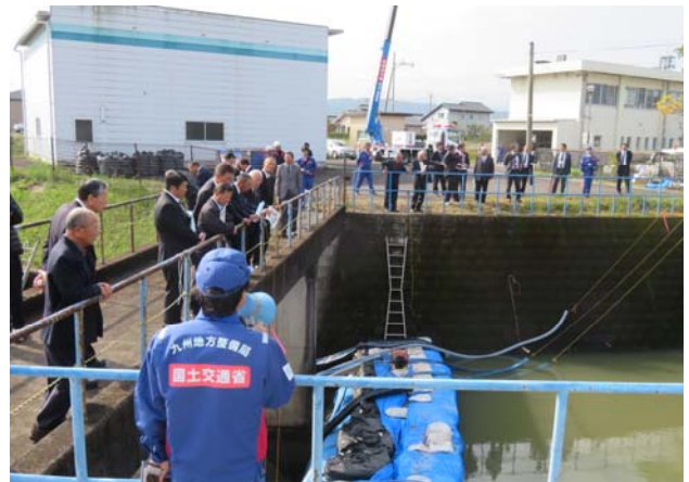
写真-1 2 排水運転状況
