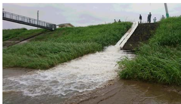
写真-2 排水ポンプ車の排水状況
