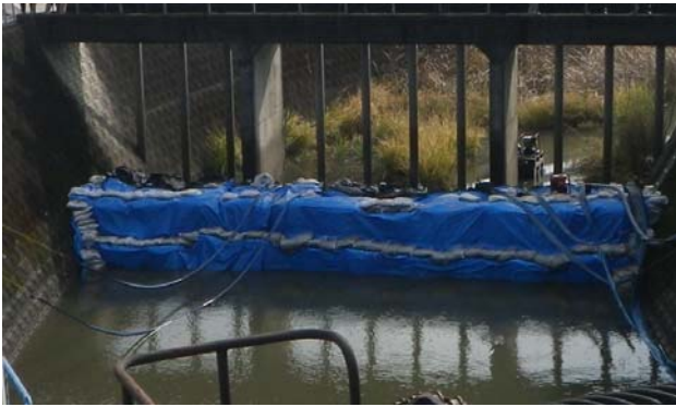
写真-6 土嚢積み、ポンプアップ状況
