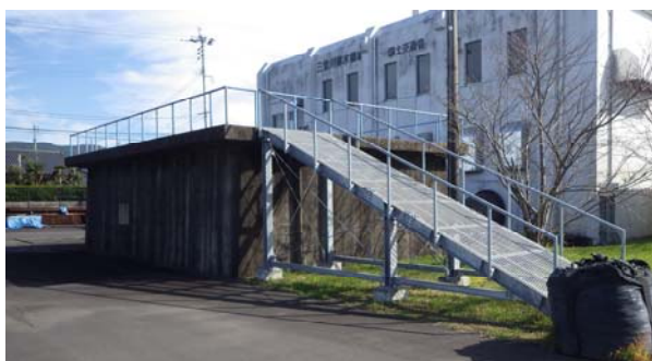
写真-4 吐出水槽上部からの排水状況確認箇所
