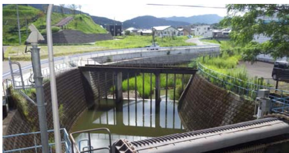
写真-3 支川側の水位低下状況確認箇所
