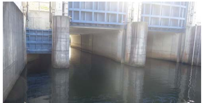
写真-5 吐出樋管からの排水状況確認箇所
