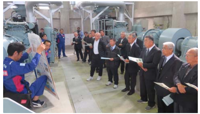
写真-1 1 排水機場概要説明状況
