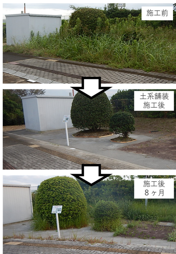
図-5 土系舗装技術のモデル施工の実施例
