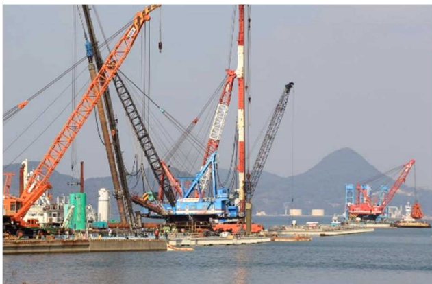
図-12 作業船輻輳状況
