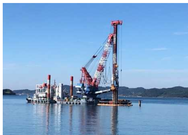
図-6 鋼管杭打設状況
