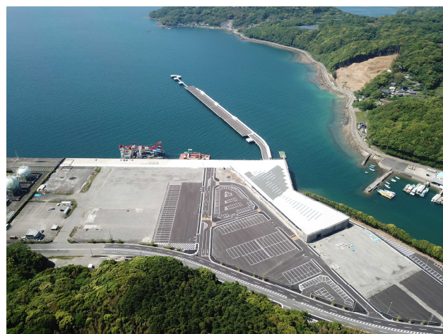
図-15 岸壁完成状況
