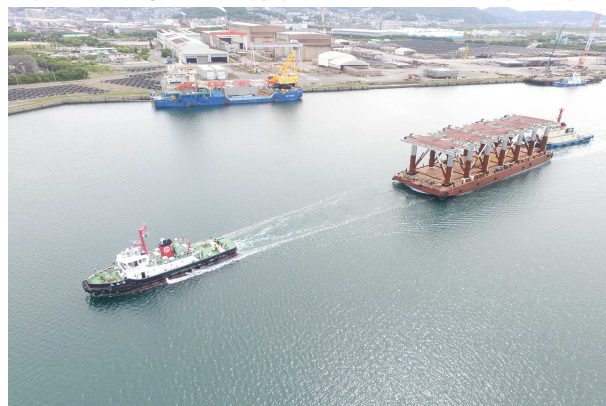
図-11 ジャケット運搬状況
