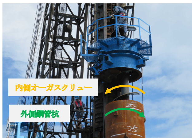
図-7 二軸同軸アースオーガ工法概観図
