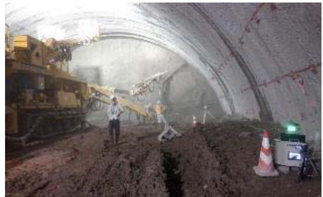
図9 現場に設置した落石検知警報装置（右側）
