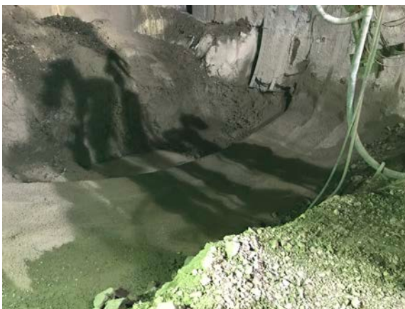
図-10 インポート吹付コンクリート
