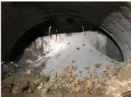
図-4 天端崩落
