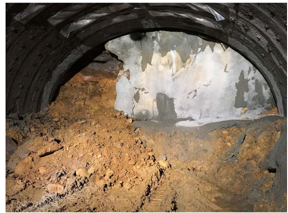
図-5 鏡面崩落
