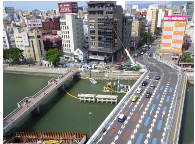
写真-2 春吉橋架替工事
