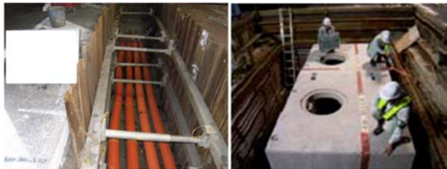
(管路埋設状況) (特殊部設置状況)
