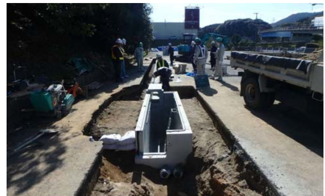
写真-6 試験施工の状況
