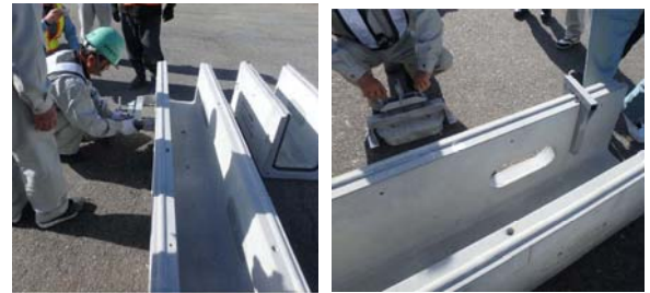
(開口作業状況) (開口後)
