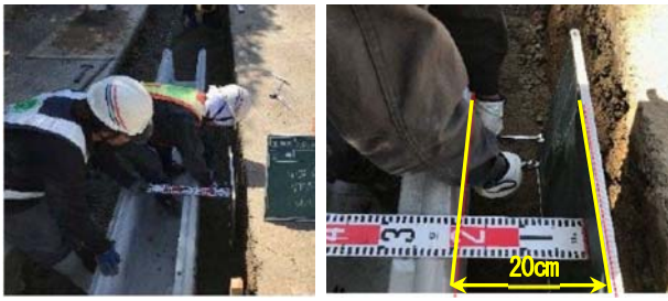
写真-7 小型ボックス施工に必要な余裕幅
