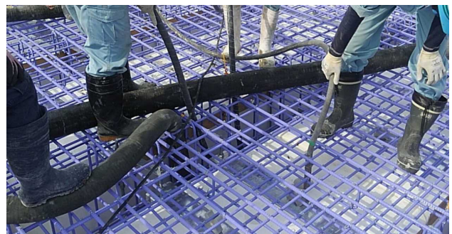
図-15 コンクリート締固め状況
