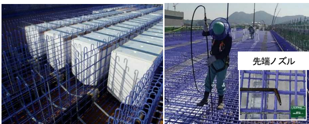
図-13 中空型枠固定・清掃状況
