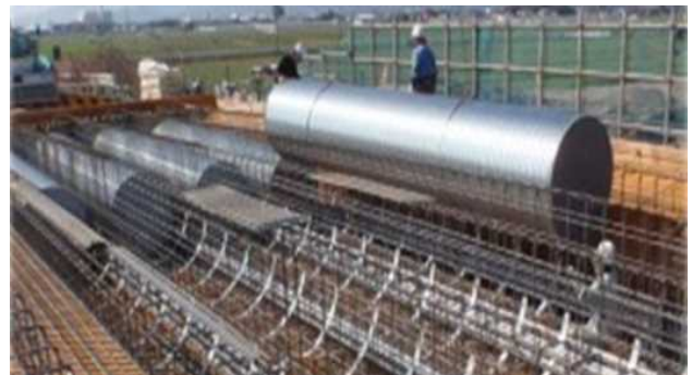
図-9 鋼製円筒埋設型枠
