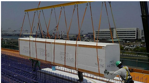
図-12 中空型枠設置状況
