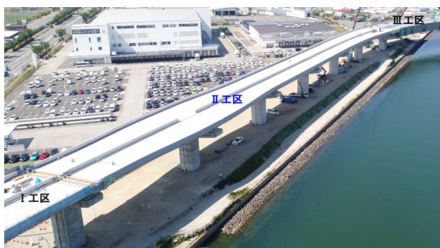
図-20 II工区完成写真（R2.5.28撮影）
