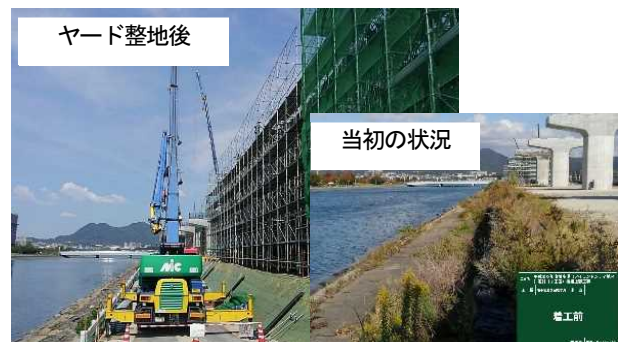
図-19 海側の施工ヤード
