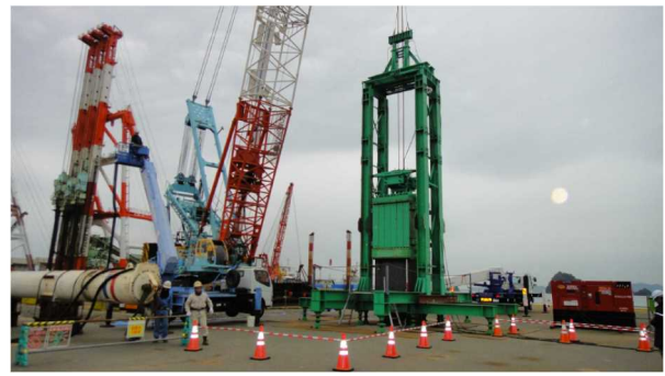
図-10 急速載荷試験全景
