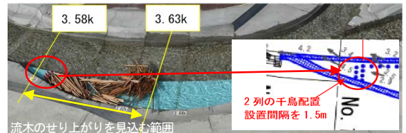
図-18 流木のせり上がり範囲（実験ケース 3-1-2）
