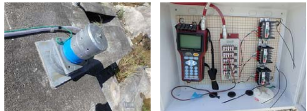
写真-2 アンカー荷重計設置写真
