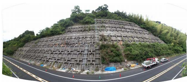
写真-1 調査地全景(アンカー施工切土法面)
