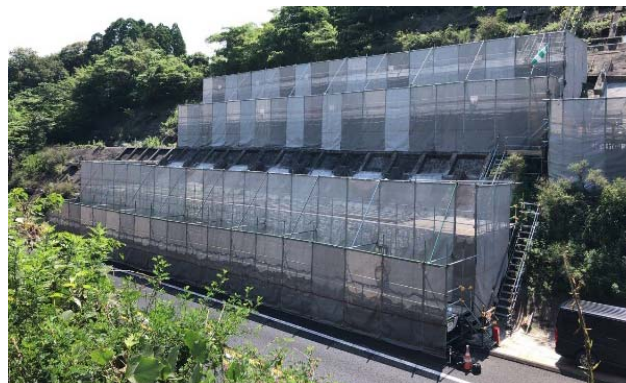
写真6 施工状況写真
