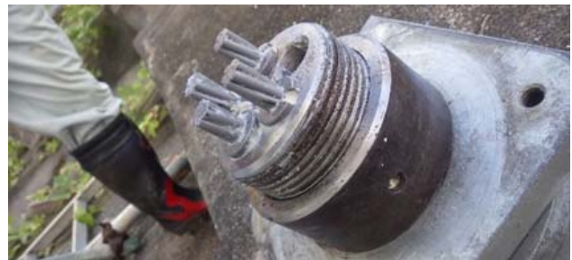
写真-3 アンカー頭部確認状況写真
