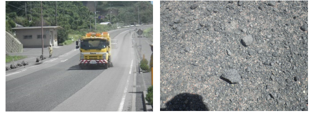
写真-5 異常時清掃 (スリップする粗い降灰)
