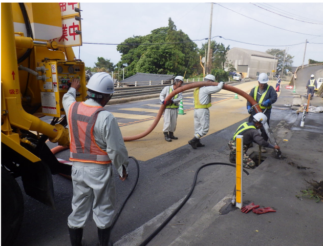
写真-9 側溝清掃の様子（手前がオペレーター）
