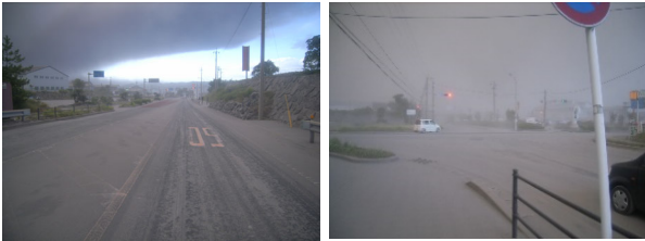
写真-3 (左) 区画線が見えない状況 写真-4 (右) 降灰多量による視界不良
