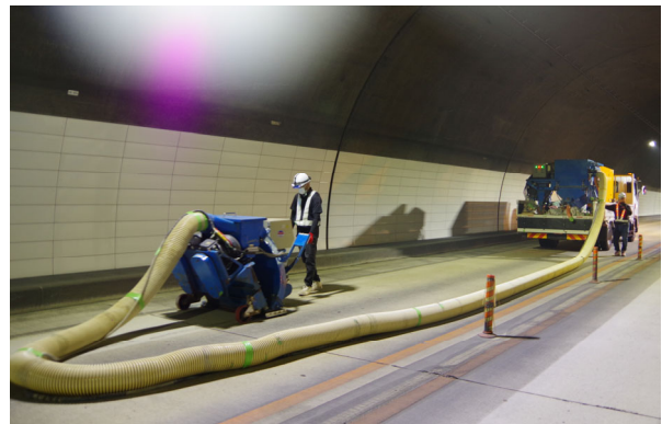
写真-2 ショットブラスト施工状況
