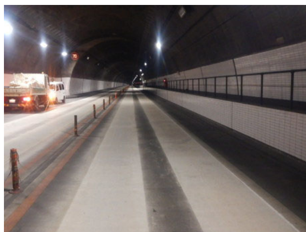
写真-11 施工後 (全景)
