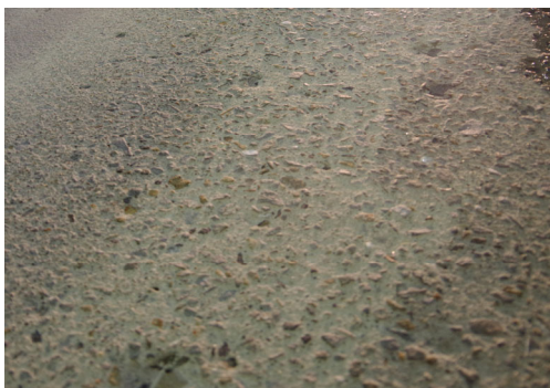
写真-9 施工後 (近接)
