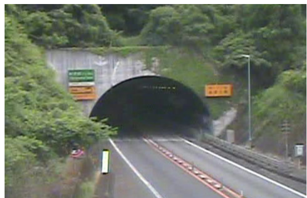
写真-1 新赤松トンネル起点坑口
