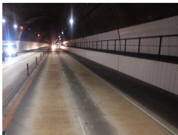
写真-10 施工前 (全景)
