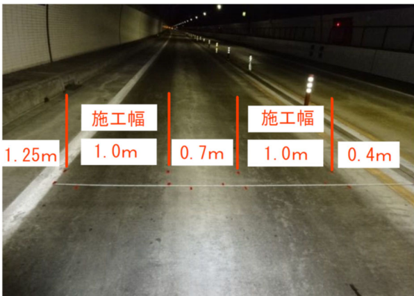
写真-3 施工箇所（下り車線） 中央未施工幅0.7m
