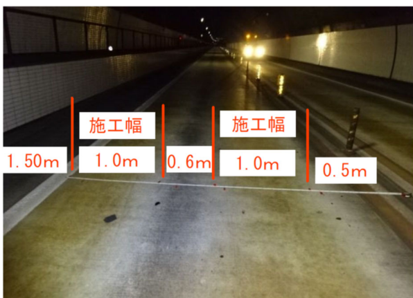
写真-4 施工箇所（上り車線） 中央未施工幅0.6m
