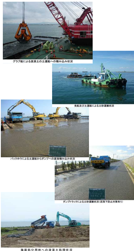
写真3 航路浚渫の作業手順
