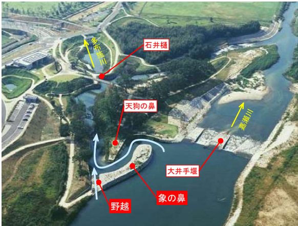
図-3 石井樋(嘉瀬川)
