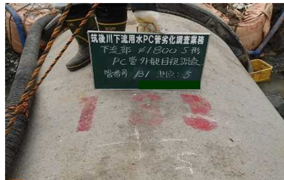
写真-2 管表面のマーキング状況
