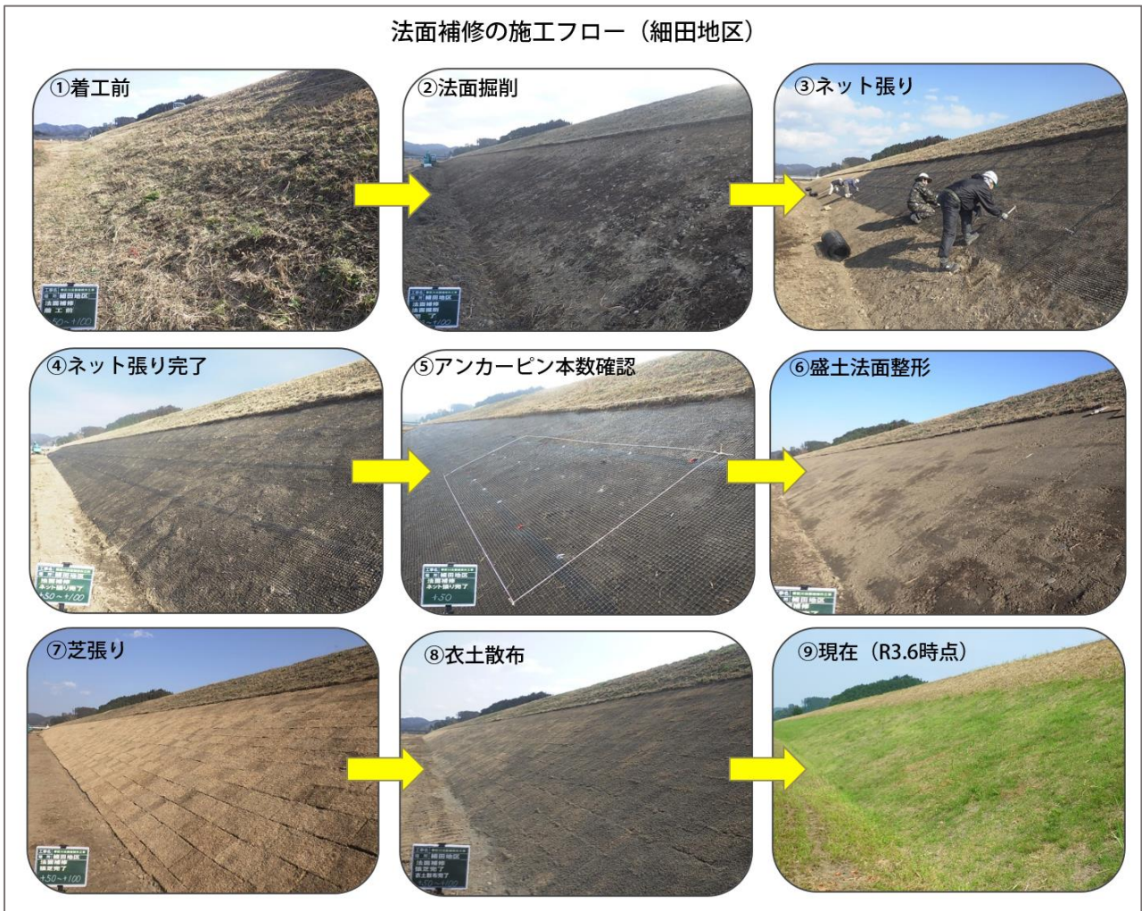
図-5 施工フロー
