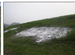
写真-10 石灰を吹き付けた法面
