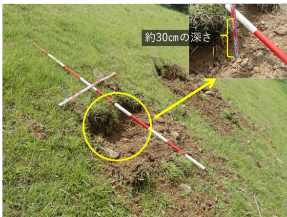
写真-1 掘り起こし被害の様子 (高島地区)
