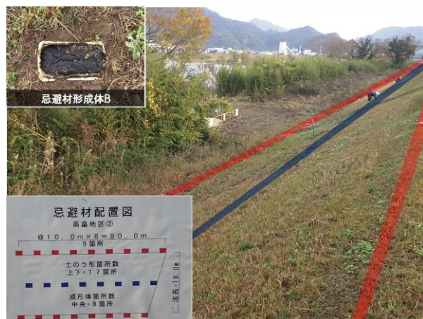
写真-8 忌避材 B の設置の様子
