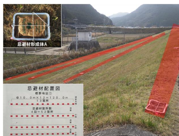
写真-7 忌避材 A の設置の様子
