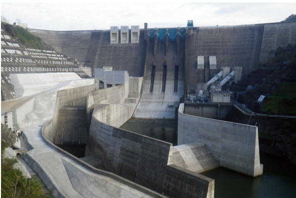
図-3 再開発事業完了後の鶴田ダム
