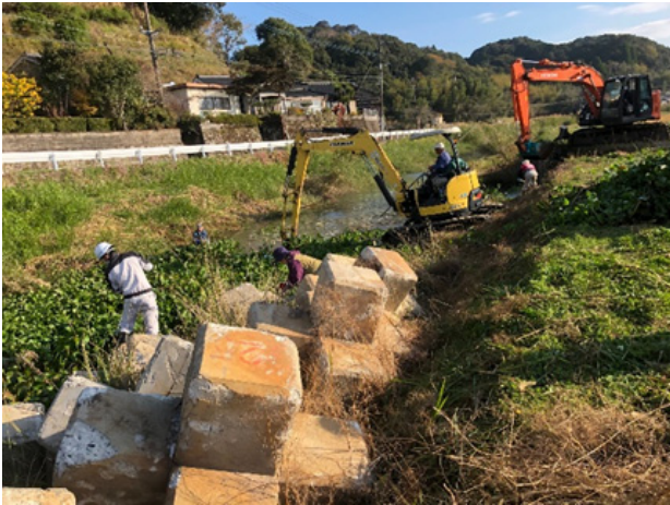
図-15 ダム上流域での外来水草の撤去作業
