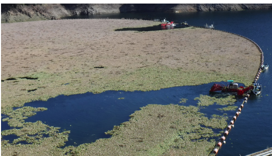
図-12 水草回収船を用いた回収の状況
