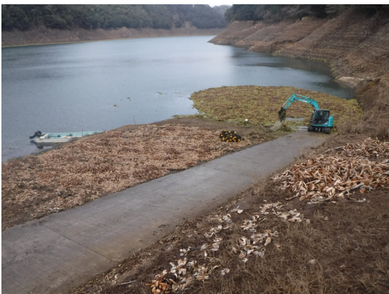
図-11 網場を用いた重機での回収の状況
