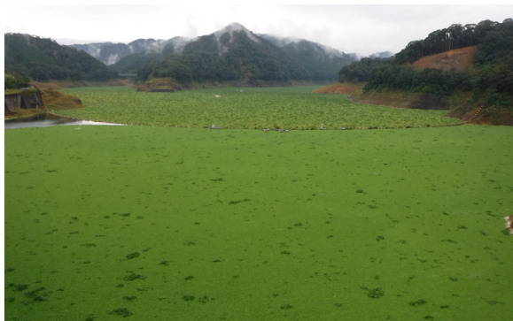
図-1 令和2年10月のダム堤体付近の繁殖状況
