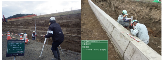
図-15 受注者による遠隔立会状況
