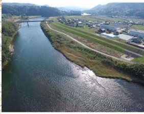
図-3 着工前写真
