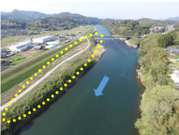
図-6 掘削箇所の写真現況
