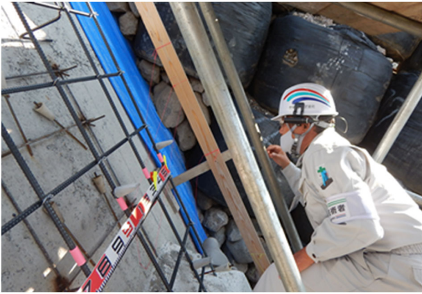
図-12 受注者がウェアラブルカメラにより鉄筋組立完了時の段階検査状況
