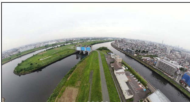
写真7 ドローンによる360°映像（関東・荒川下流）
