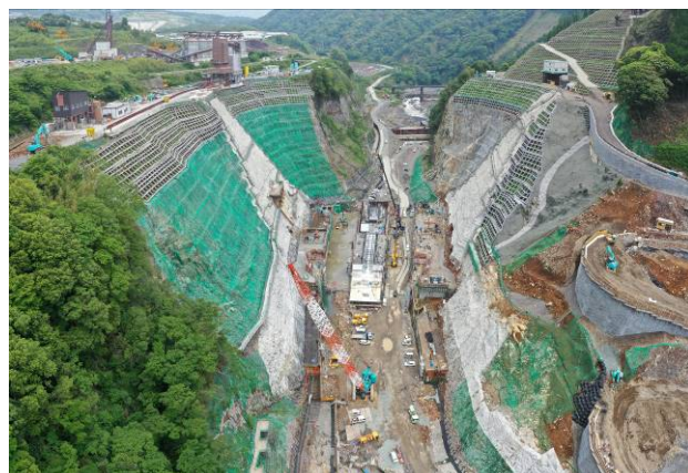
図-10 立野ダム工事状況（堤体下流より上流を望む）
