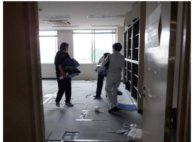
写真－9 不要物の搬出状況
