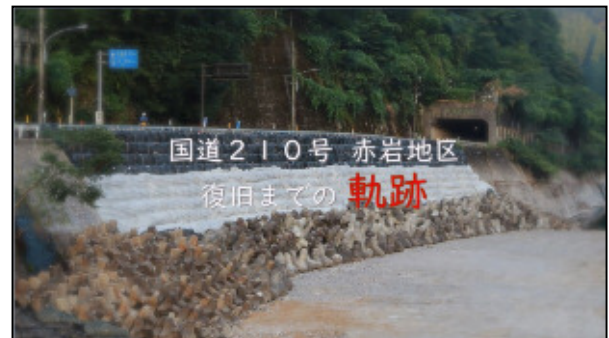
写真-9 国道210号 赤岩地区 復旧までの軌跡
