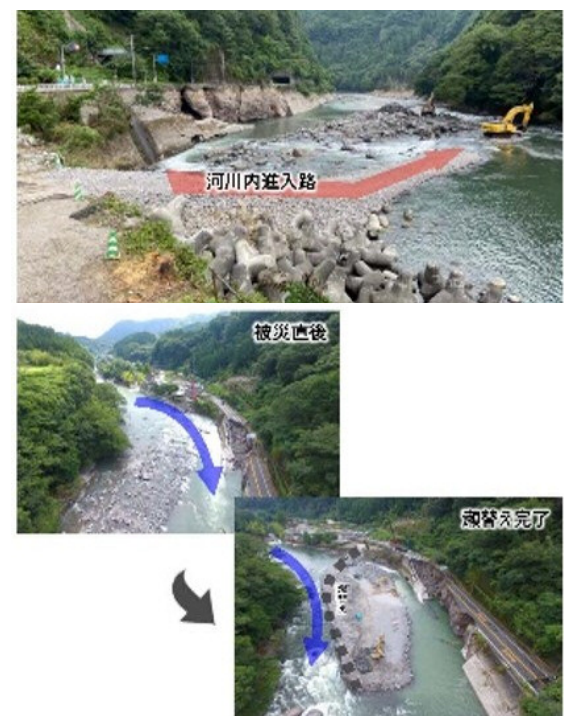
写真-6 河川内進入路の設置及び瀬替え状況
