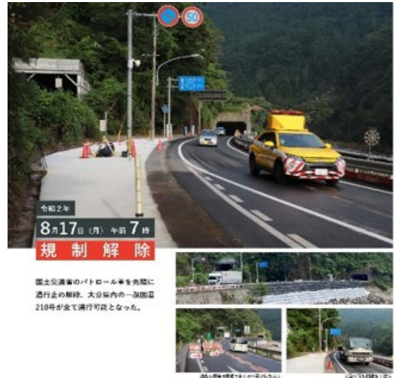
写真-7 応急復旧完了に伴う規制解除
