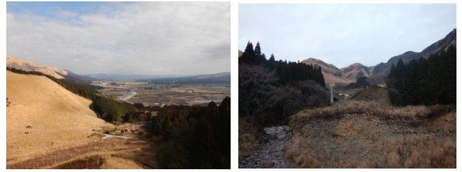
図-8 視認性の高い堰堤（左）と視認性の低い堰堤（右）
