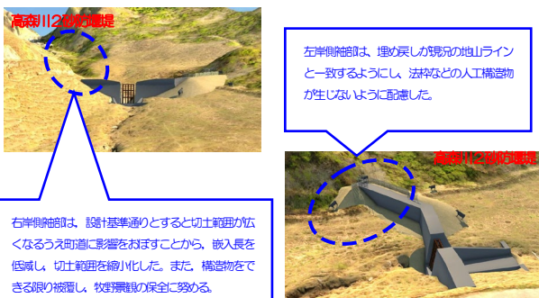
図-16 砂防堰堤完成イメージ（高森川2）
