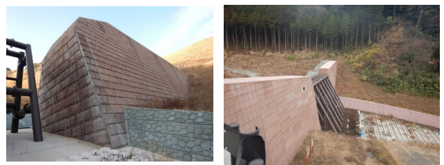
図-10 INSEM 堰堤 外部保護材事例
