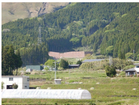
図-11 視認性が高く保全対象が接近している事例
