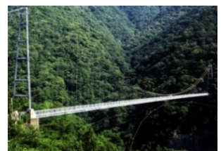
写真ー2 照葉大吊橋 (綾町)
