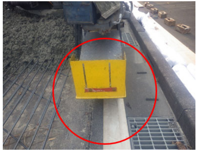
写真3 スリップフォーム機械一部
