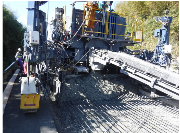
写真1 連続鉄筋コンクリート舗装施工状況
