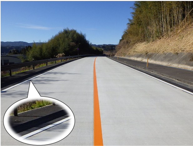
写真5 コンクリート舗装施工後
