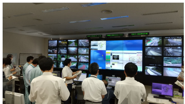
図-8 新しい道路情報板制御装置の操作説明会の様子
